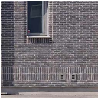
Tegel ned till låg sockel
